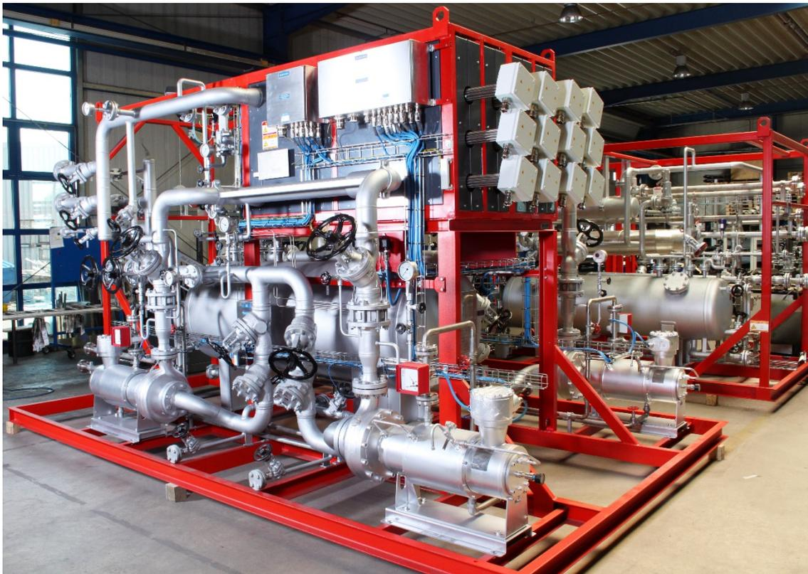
Abbildung 3: Elektrischer Thermalölerhitzer für petrochemische Anwendungen mit Einschweißventilen und Spaltrohrmotorpumpen (Quelle: heat11)
